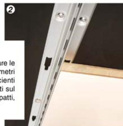
**INCASTRO DEL PANNELLO:** dopo aver fissato il profilo al muro far scivolare le viti nel profilo stesso. Per un pannello di tre metri destinato ad un carico modesto sono sufficienti 4/5 viti per lato. Per elementi a sbalzo fissati sul pannello, o per utilizzo di materiali poco compatti, aumentare il numero di viti.
